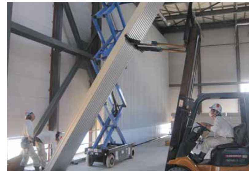
断熱パネルの取り付け作業
