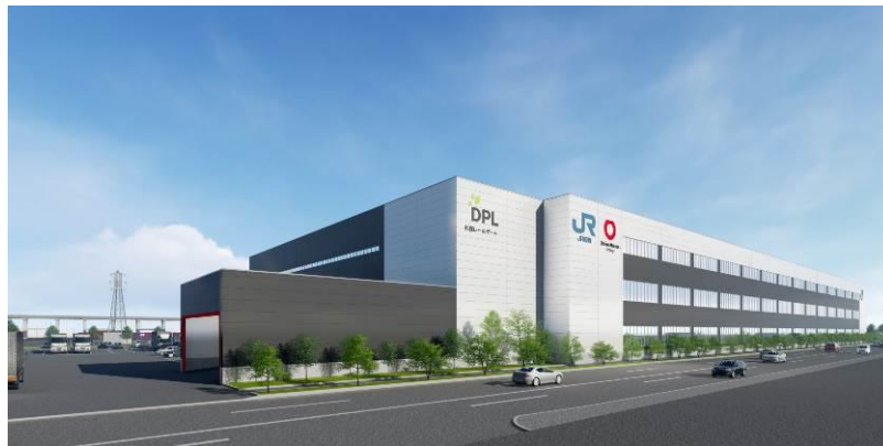
「DPL札幌レールゲート」外観パース
