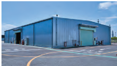
危険物対応可能な8号倉庫
