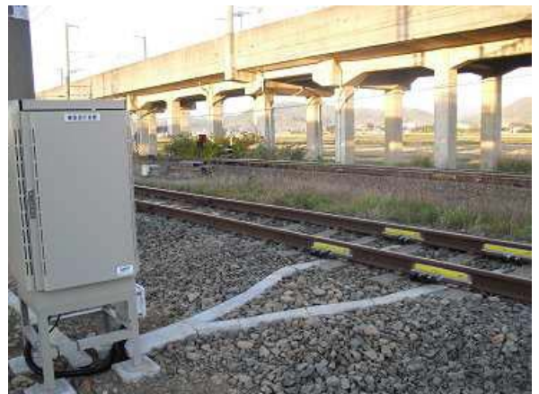
歪みゲージの設置完了
