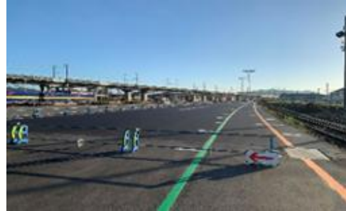
新南陽駅改良工事
