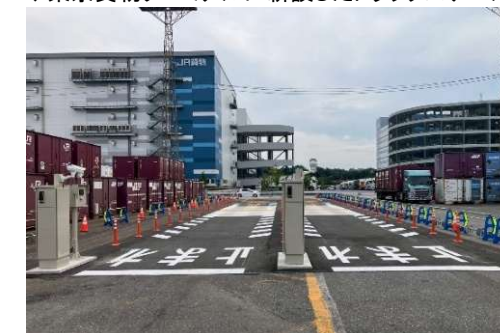
◆東京貨物ターミナルに新設したトラックスケール
