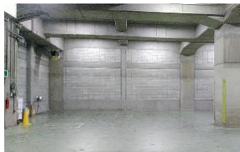
積替ステーション併設倉庫
