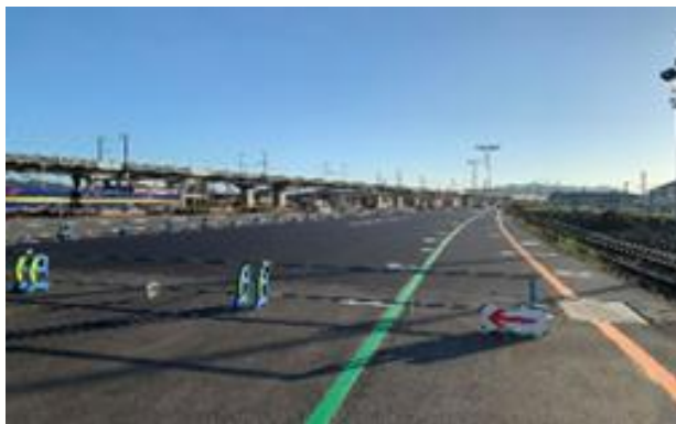
新南陽駅改良工事
