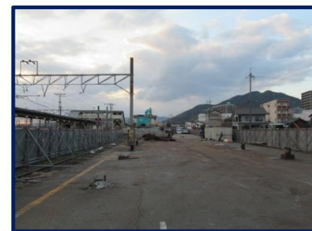
◆新南陽駅のコンテナホーム拡張工事
