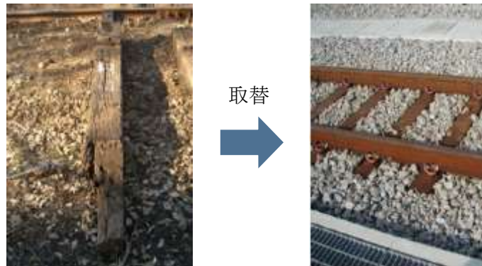
工事例：木まくらぎの鉄まくらぎへの取替
