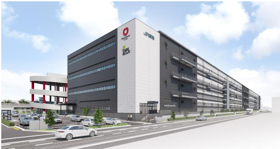
【「DPL千葉レールゲート」イメージパース】
