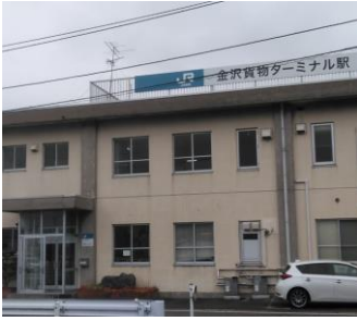
金沢貨物ターミナル駅 金沢市高柳町5-1-1 東金沢駅 最寄り
