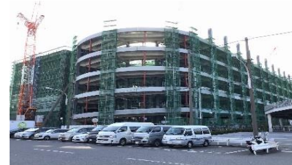
← WEST建設状況 10/31敷地北東側から
