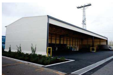
東京貨物ターミナル駅積替え施設
