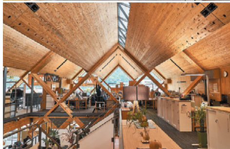
集成材とCLTを活用した本社事務所
