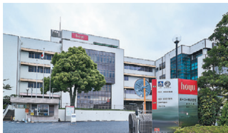
瀬戸工場・物流センター
