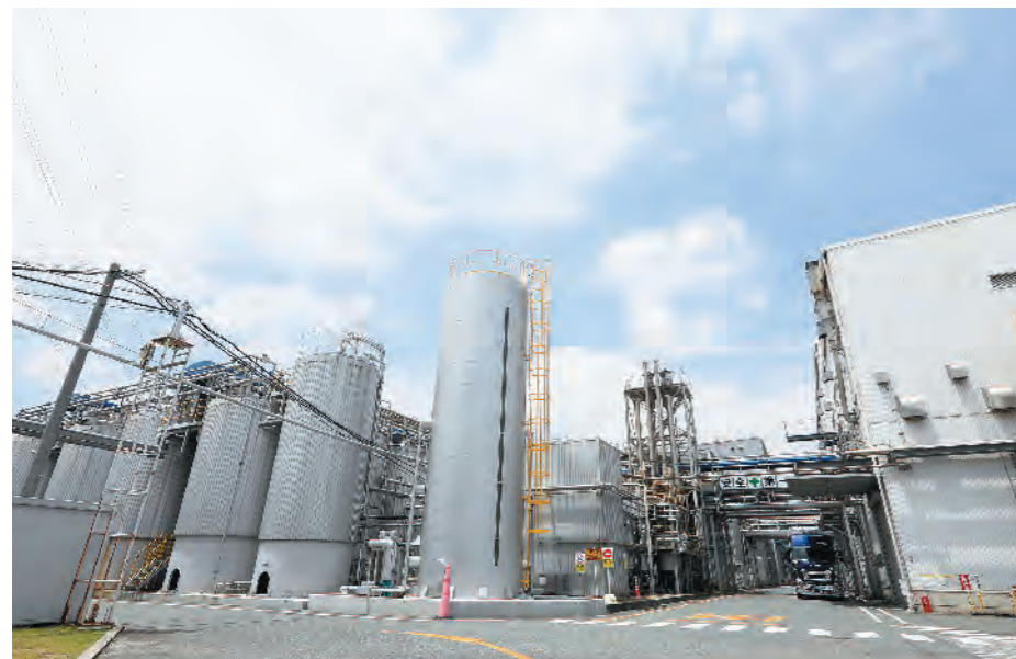
24時間稼働する岡山機能糖質工場
