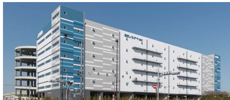
レー尔ゲートWEST(物流施設)
