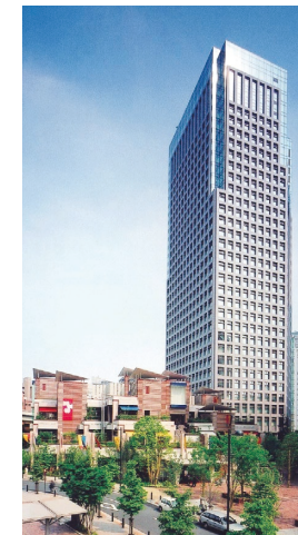
ガーデンエタワー(オフィスビル)・アイガーデンテラス(商業施設)
