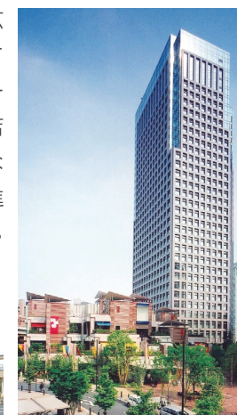
アイガーデンエアタワー(オフィスビル)・アイガーデンテラス(商業施設)
