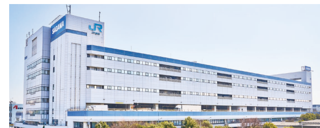
エフ・プラザ東京A棟(物流施設)
