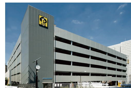
八王子駅南口立体駐車場(駐車場)
