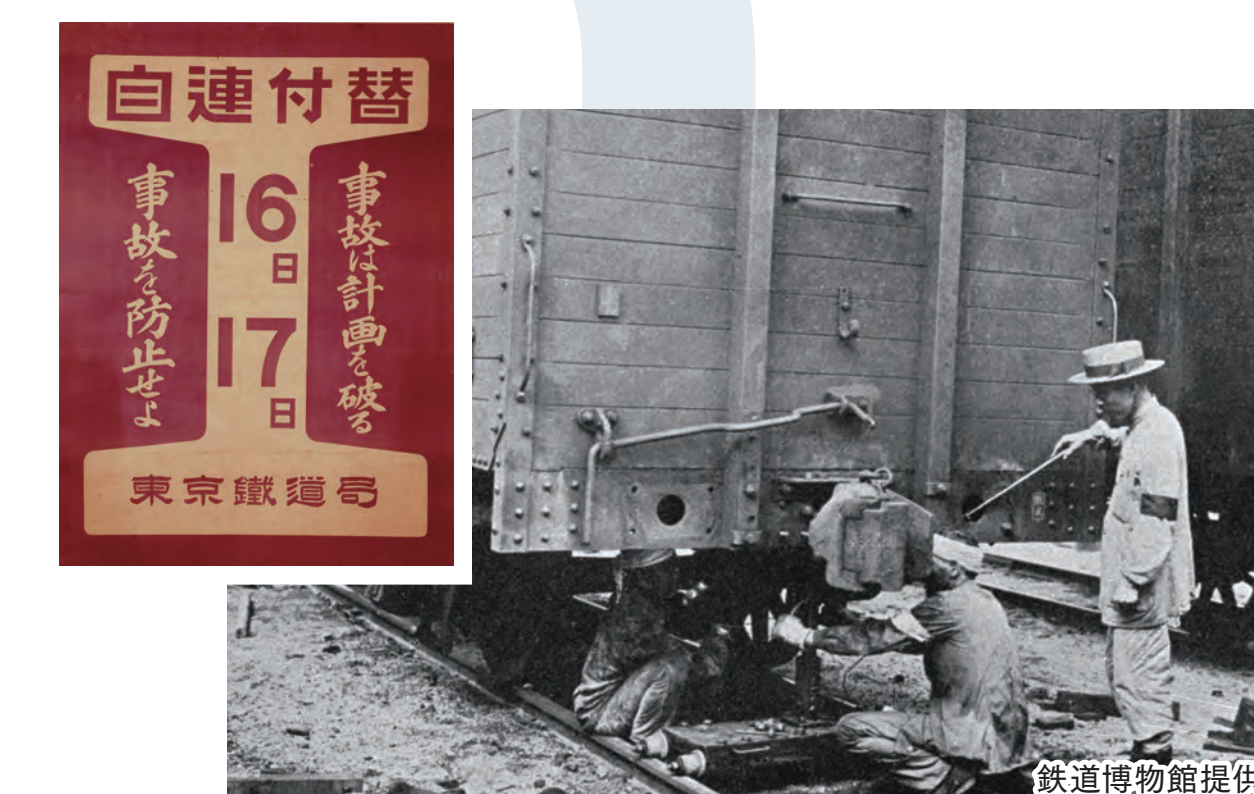
1925年7月17日 本州線・讃岐線(四国)ならびに連絡会社線で一斉に貨車の自動連結器付替作業を施行
