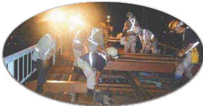
橋まくらぎの取替え作業
