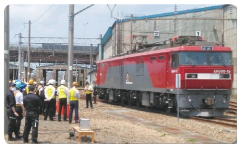
旅客会社との合同脱線復旧訓練
