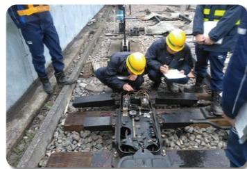
電気転つ機の配線に関する実習
