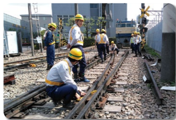
軌道検査に関する実習
