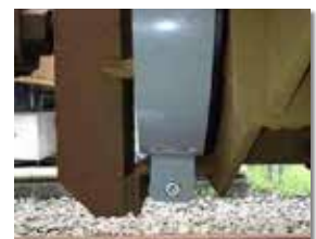
雪侵入防護カバーの取付
