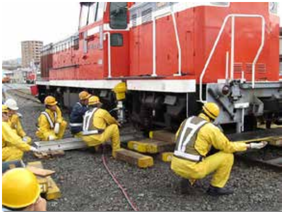
旅客会社と合同の脱線復旧訓練
