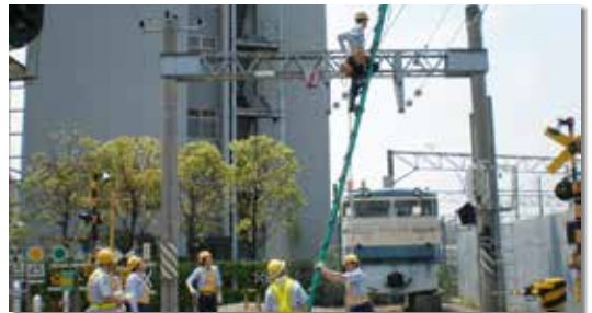
電車線検査実習
