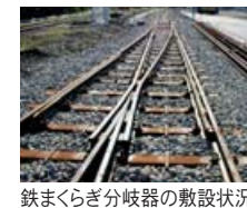
鉄まくらぎ分岐器の敷設状況
