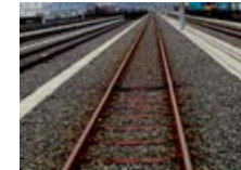
鉄まくらぎの敷設状況
