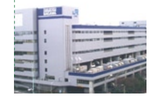
エフ・プラザA棟
