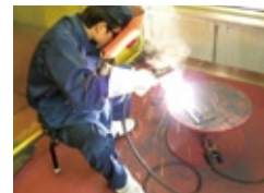
電気で溶接するアーク溶接
