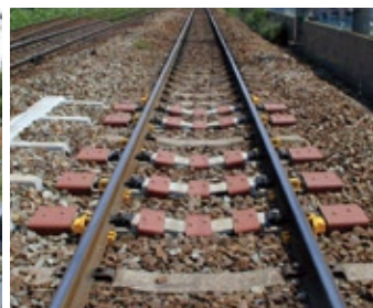
フラット検知装置のセンサー部
