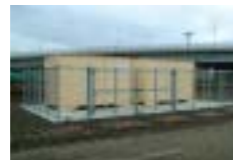
PCB保管庫 (札幌貨物ターミナル駅構内)
