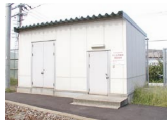
金沢保全区PCB保管庫
