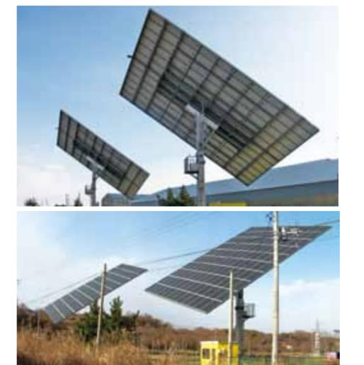
設置した太陽光追尾型発電システム
