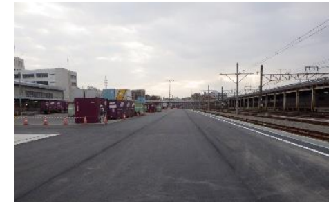
横浜羽沢駅E&Sホーム
