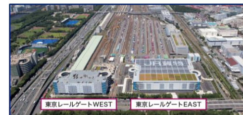
◆稼働中の東京レールゲート (東京貨物ターミナル駅構内)
