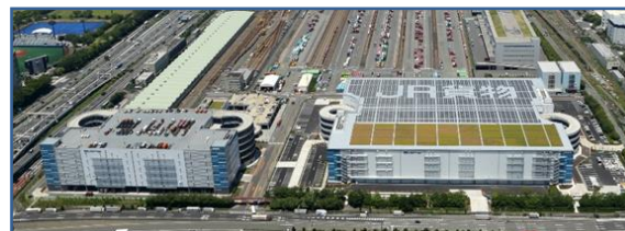
東京レールゲート(左:WEST、右: EAST)
