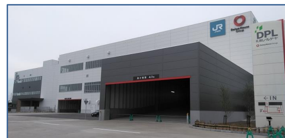
DPL札幌レールゲート
