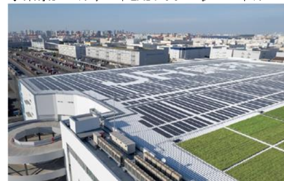
◆東京レールゲートEASTのソーラーパネル
