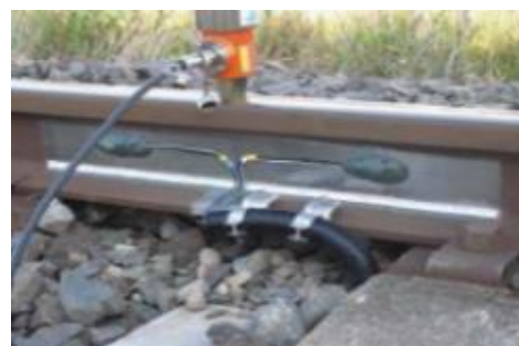
輪重測定装置
