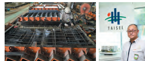
PC階段の段床製造
