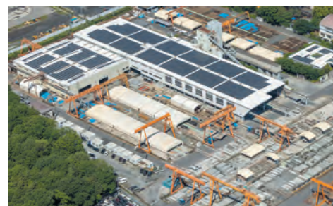
川越工場に設置されたメガソーラー
