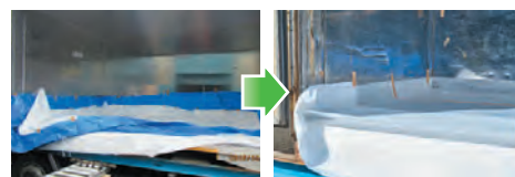
考案した専用ボードで養生作業を効率化
