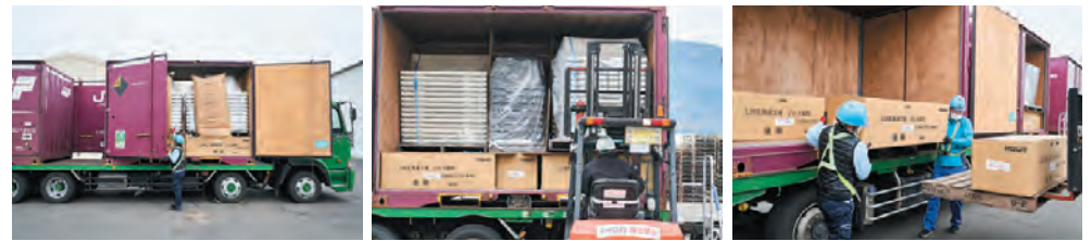
到着したコンテナから浴槽など中間仕掛品や部材を取り卸す
