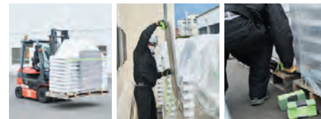
取り卸した浴槽
